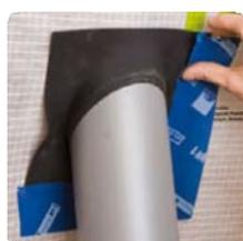
Les lés du film étanche à l'air (polyéthylène par exemple) sont collés au moyen d'une bande adhésive. Cette même bande est utilisée pour obturer les trous résultant de l'agrafage.
